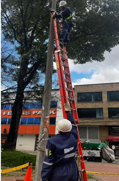
Trabajo en poste acceso escalera
