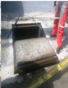
Levante totalmente la tapa de la cámara y descarguela hasta dejarla sostenida sobre un soporte sólido (taco de madera).
