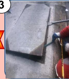
Ubique la herramienta (barra) en el borde de la tapa y genere fuerza entre la barra y la tapa hacia abajo utilizando la barra como palanca, otro colaborador debe ubicar la patecabra en la otra esquina de la cámara y descargue la tapa.
