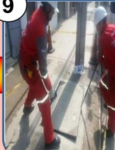
Deje deslizar la tapa de la cámara lentamente hasta que cierre y Ajuste la tapa al marco de la cámara.
