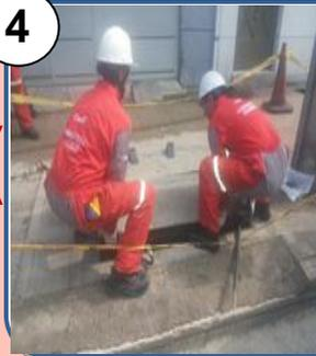
Ubique la barra en la otra esquina haciendo apalancamiento entre la tapa y el borde de la cámara al igual que la patecabra, generando un espacio entre la tapa y el borde de la cámara, y proceda a levantar la tapa entre dos personas.
