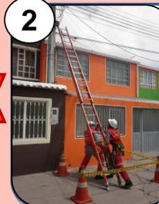
Coloque la escalera sobre la fachada, asegurándose de que las zapatas queden sobre un terreno firme y nivelado y que la parte superior quede apoyada sobre un sitio estable y seguro
