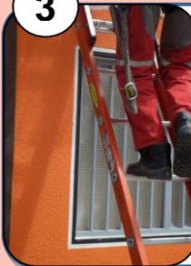
Asegure la escalera con una cuerda a una reja o estructura de la fachada con el fin de que no se resbale
