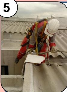
Haga un nudo ocho al extremo de la cuerda y conecte esta con un mosquetón a la argolla frontal del arnés, así mismo la silla de trabajo al mismo punto. Tensione la cuerda desde el descendedor. Instale el freno de cuerda en la línea de vida vertical y conecte la eslinga con absorbente de choque a la argolla dorsal. Una vez este asegurado dispóngase para descender.
