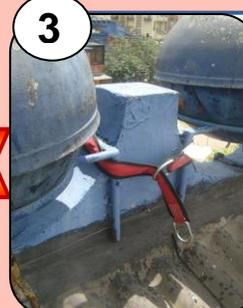
Abrace con una banda de anclaje Tie Off, cinta tubular, mosquetones o cuerda las estructuras que haya escogido como más resistentes; haga una anclaje en "V" cogido de dos puntos para mejorar la resistencia. Este proceso se repetirá para la Línea de vida vertical y la línea de descenso.
