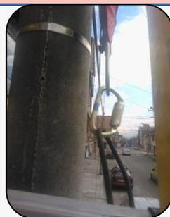
Conecte su Tie Off al poste debajo de los cables y luego una con un mosquetón el Tie off y la cuerda que aseguró al paral de la escalera
