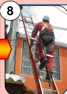
Ascienda hasta el sitio de labor asegurado a la línea de vida con su freno y manteniendo siempre tres puntos de apoyo.
